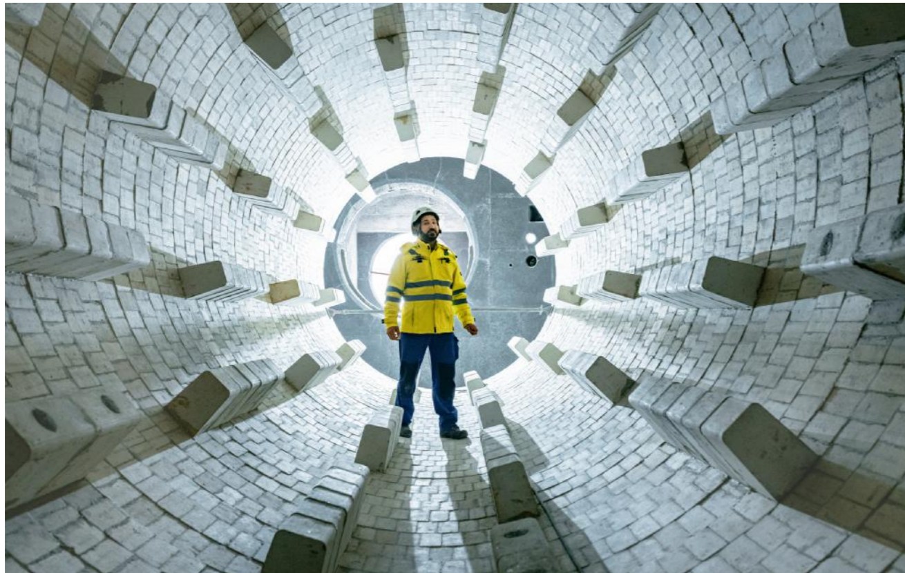
10 Vergrünung der Fernwärme Zum Beispiel in der neuen Verwertungsanlage für Klärschlamm auf der Friesenheimer Insel
