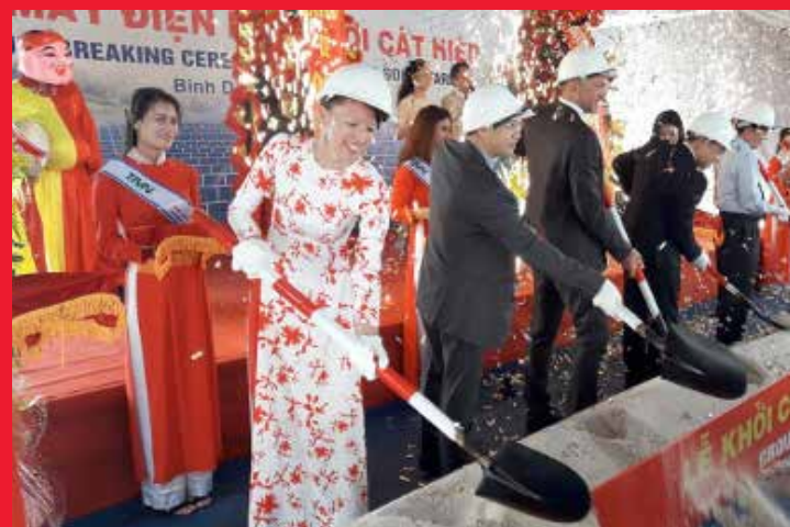
Spatenstich für den vietnamesischen Solarpark in der Cat Hiep, Binh Dinh Provinz
