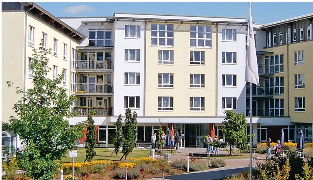
Energiepartnerschaft in Kaiserslautern – Seniorenzentrum des DRK-Landesverbands Rheinland-Pfalz
