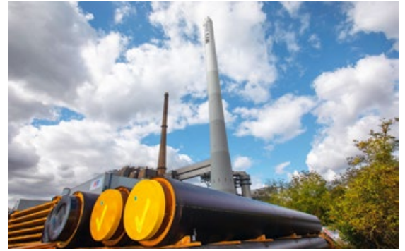
Die Vorbereitungen für die Anbindung laufen bereits...
