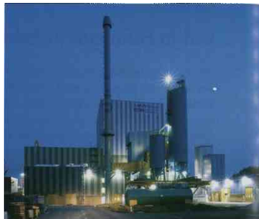
Das modernste Biomassekraftwerk Europas befindet sich im Nordhafen der brandenburgischen Stadt Königs Wusterhausen
